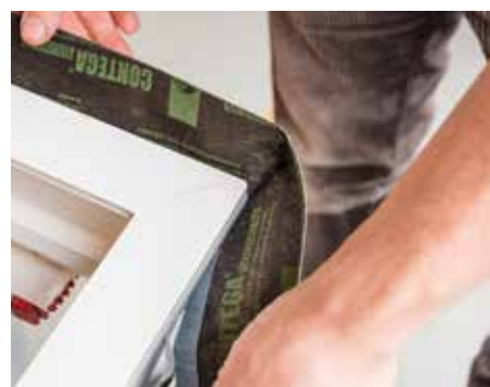
Eckschleife herstellen (Länge: 1,5 x Fugenbreite).
