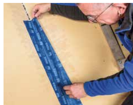
... geprimerten Holzfaserplatten
