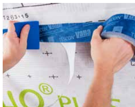
Verklebung von Bahnenüberlappungen innen,
