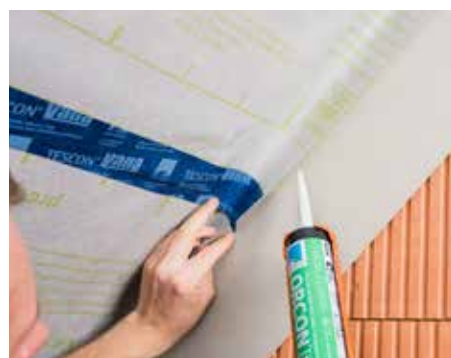
Anschlusskleber für Luftdichtungsbahnen innen,
