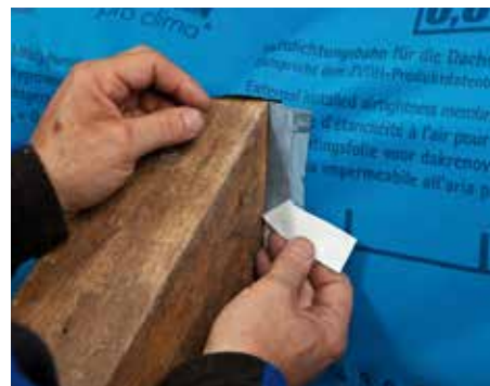
Trennfolie ablösen: Bahn und Sparren luftdicht verkleben.
