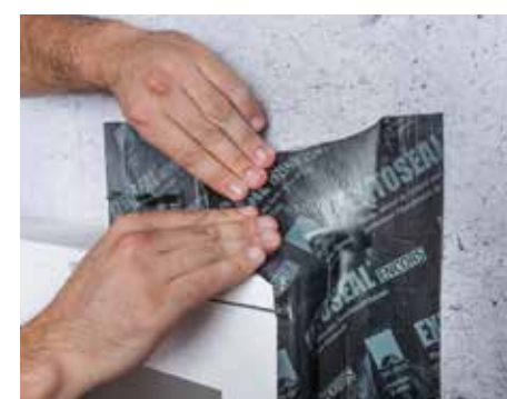
In Eckbereichen extrem dehnfähig.
