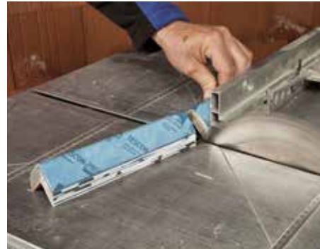
TESCON FIX auf gewünschte Länge ablängen
