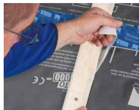
Trennpapier Zug um Zug entfernen.
