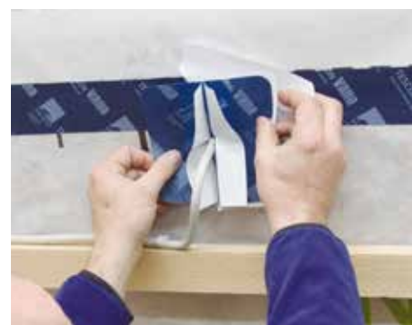
KAFLEX post, wenn das Kabelende nicht mehr zugänglich ist.
