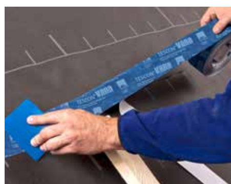
und Bahnenüberlappungen außen.
