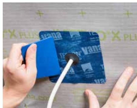
KAFLEX mono für ein Kabel.
