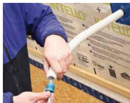
STOPPA dichtet Kabel in Leerrohren ab.
