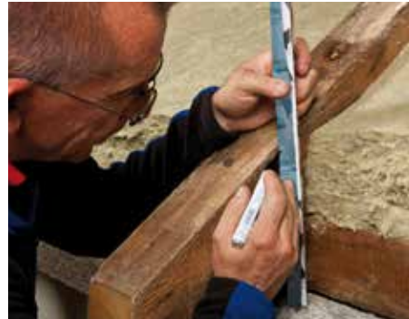
Erforderliche Länge anzeichnen.
