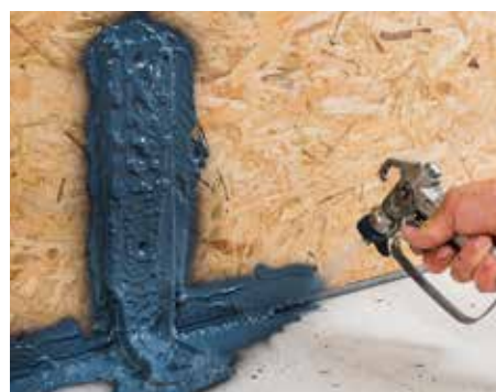
Luftdichtes Übersprühen von Befestigungswinkeln,
