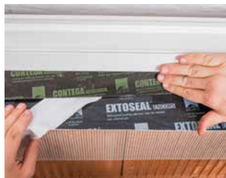
Fenster einsetzen, Trennfolie abziehen und umlaufend in der Leibung verkleben.
