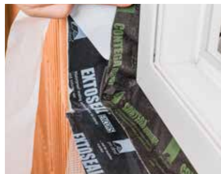
In Ecken luft- bzw. schlagregendicht verkleben.
