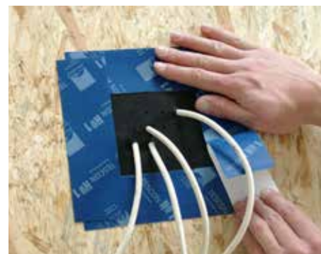
KAFLEX multi für bis zu 16 Kabel.
