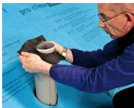
ROFLEX 100: Einsatz außen.
