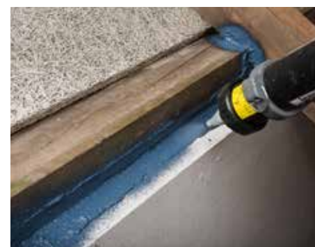
... in schwierigen Sanierungssituationen.
