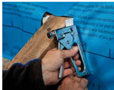
Bahn an Leiste feststuckern.
