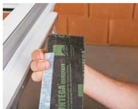
Trennfolienstreifen abziehen.
