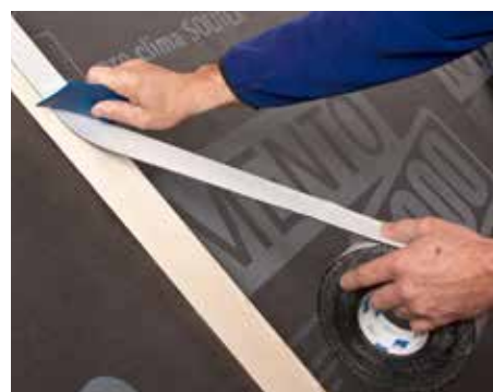
Band auf die Konterlatte aufkleben.
