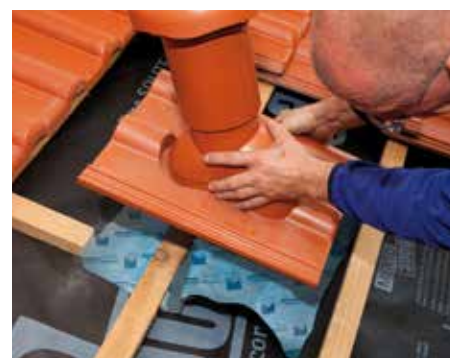
ROFLEX exto für einfaches Verkleben unter Dunstrohrpfannen.
