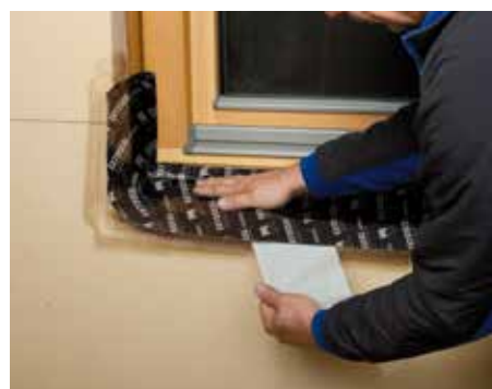
Einsatz als wasserdichte Unterfensterbank.
